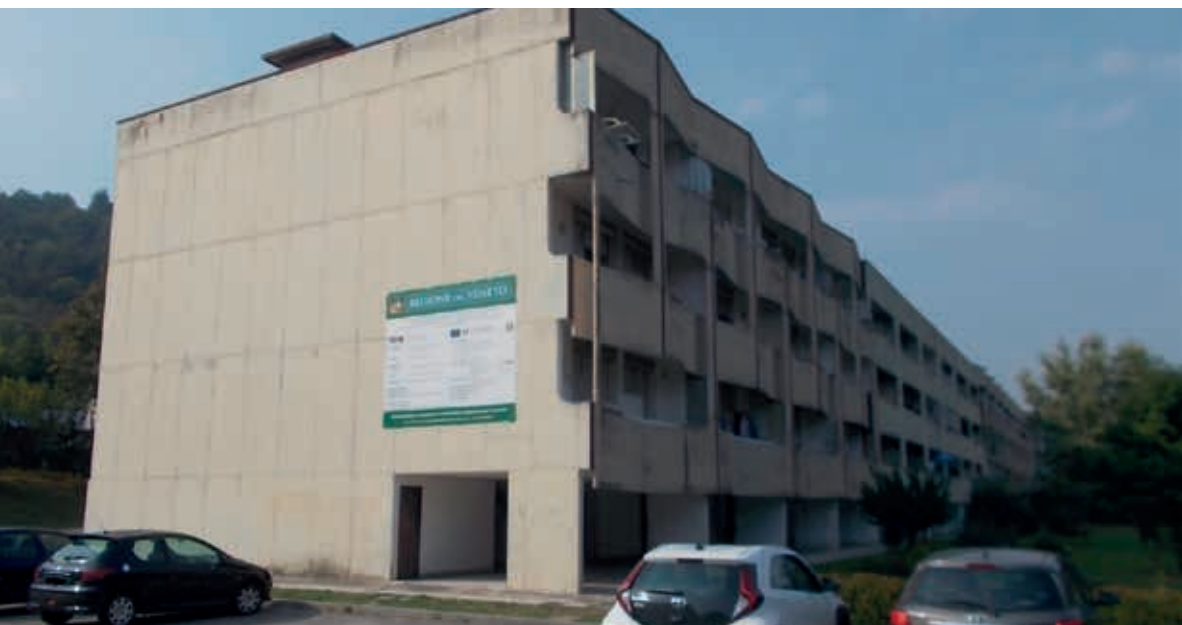
Il complesso immobiliare di via Aldo Moro prima dei lavori
