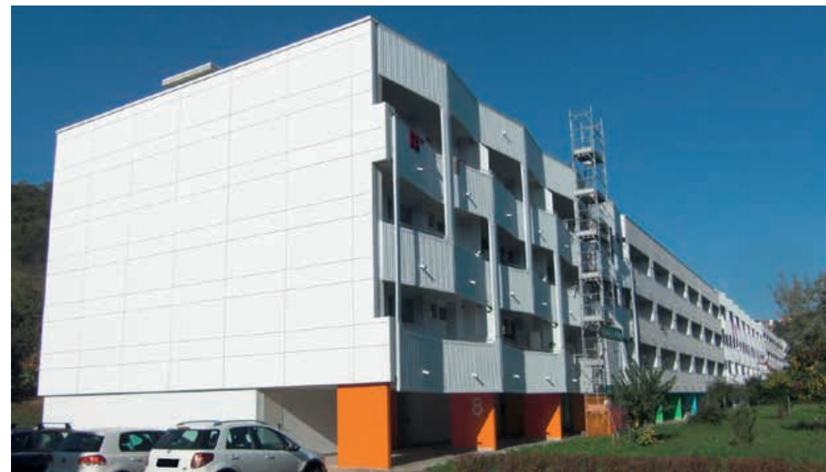
L'edificio dopo l'intervento, collaudo previsto ad inizio 2025
