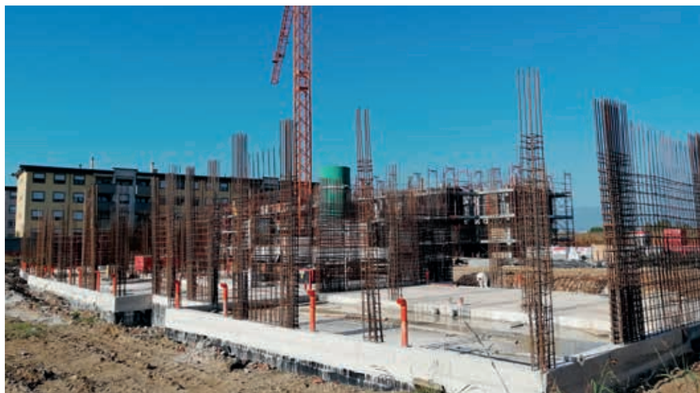
Lavori in corso al cantiere di Laghetto a Vicenza
