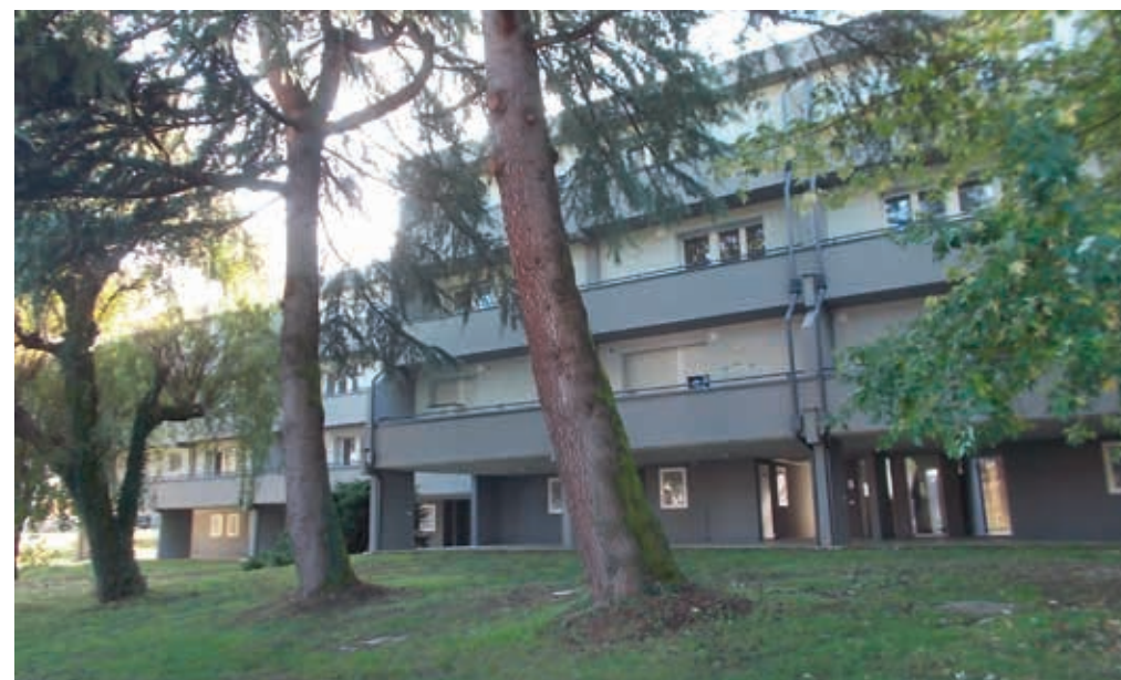
L'edificio di Valdagno in via Giolitti, lavori in fase di completamento
