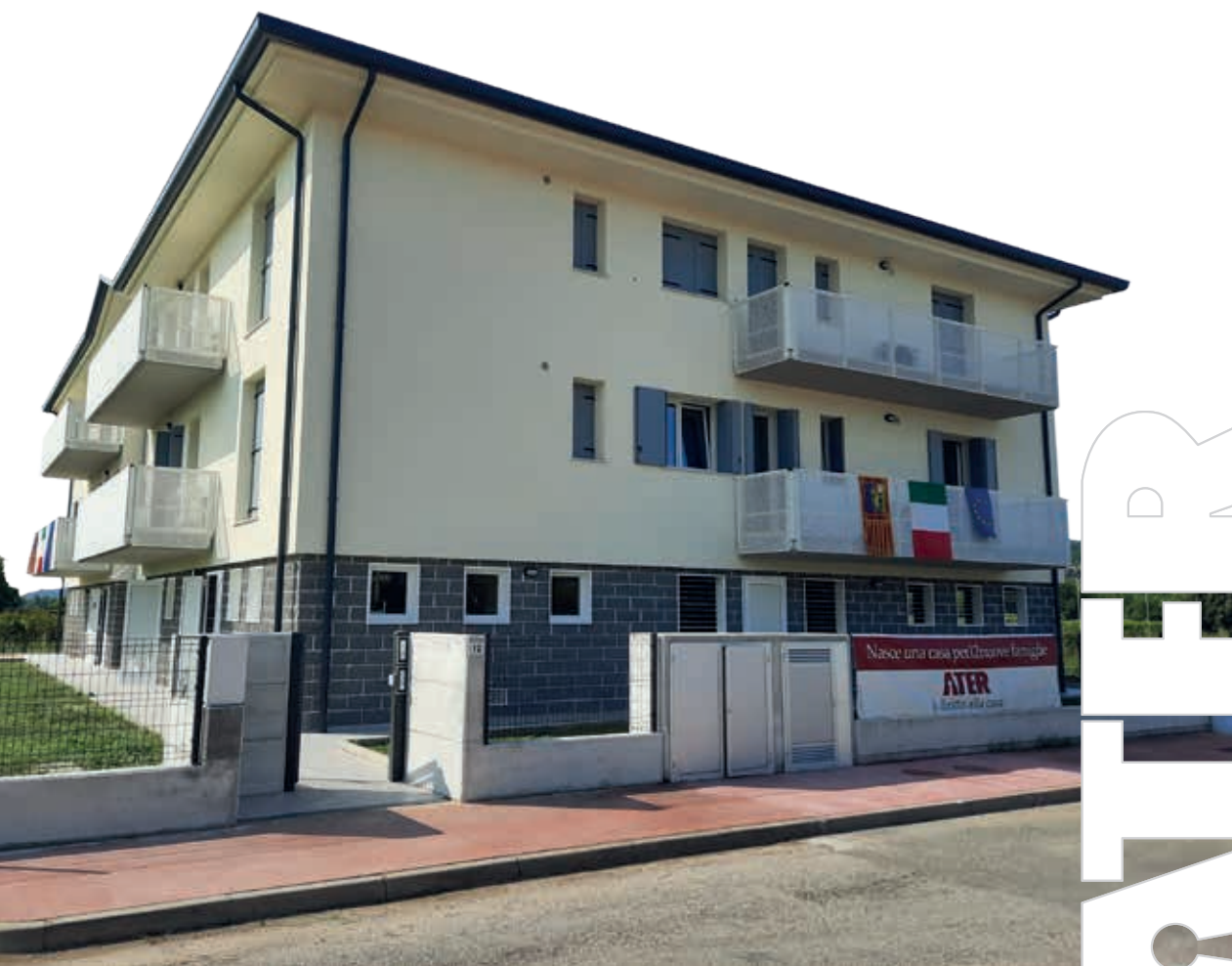
La nuova palazzina costruita a Tezze in via S. Barbara
