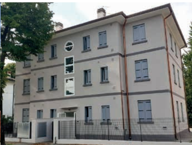
La palazzina a lavori ultimati
