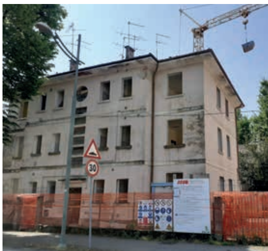
L'edificio di via Verdi prima dell'intervento
