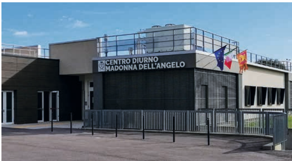
La struttura a servizio degli anziani in via Stadio
