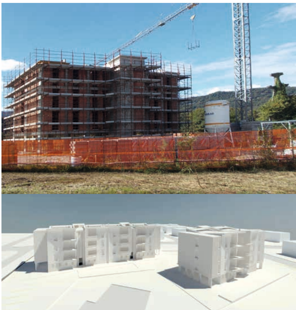
Sopra i lavori in corso in via Tuzzi, sotto il rendering degli edifici
