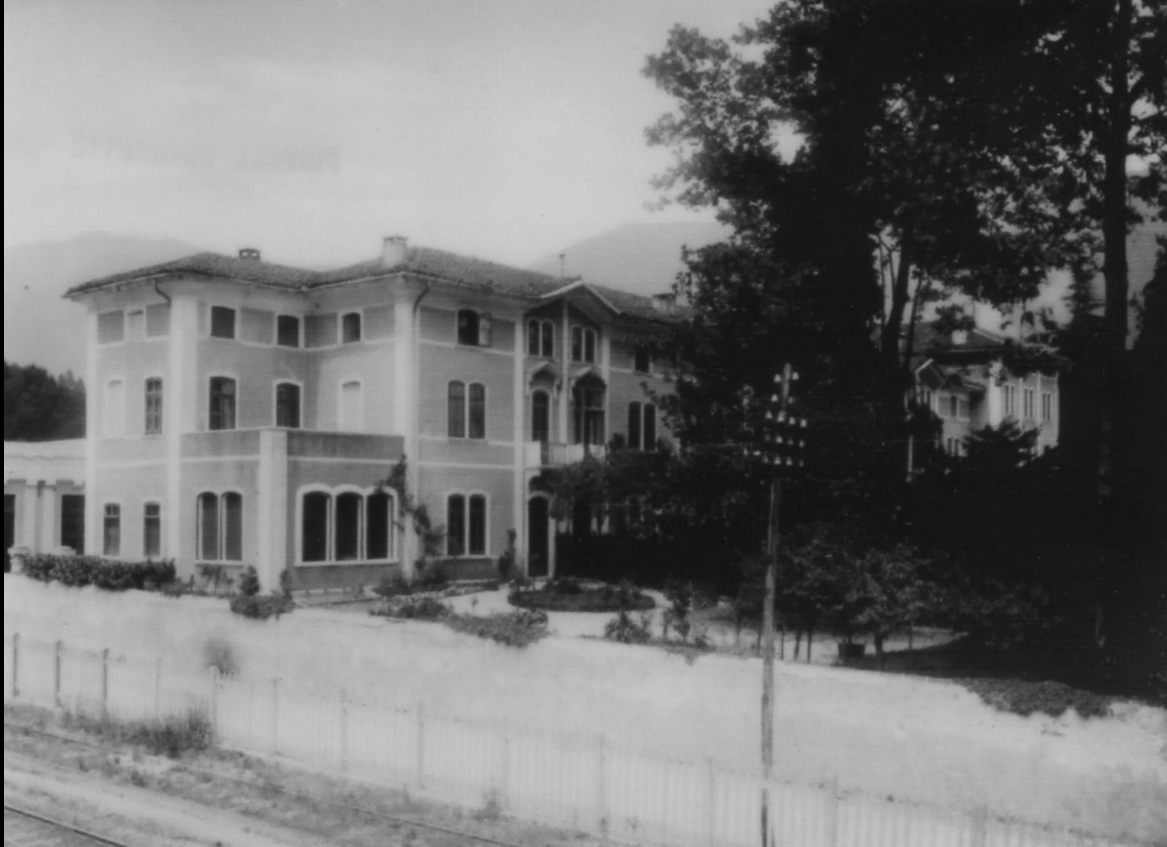
Il signorile edificio degli impiegati, edificato su tre livelli, situato nelle vicinanze dello stabilimento n°3, e confinante con il binario della Piovene- Arsiero
