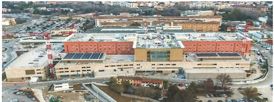
Foto: Cittadella di Treviso in costruzione
