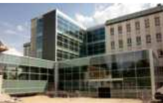
Opere di adeguamento barriere architettoniche e sicurezza del Seminario novecentesco di Vicenza per affittanza ULSS n. 6 Vicenza
