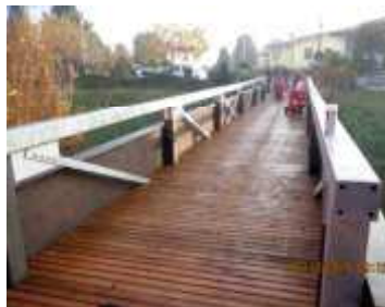
Intervento di restauro e consolidamento della passerella ciclo-pedonale “Zona Marzemine”
