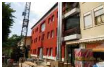
Ristrutturazione per l'adeguamento alla L.R. 22/2002 - Primo Stralcio - Casa di Riposo Barbarano Vicentino (VI)
