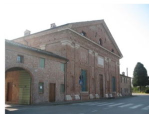
Veduta del fronte nord
